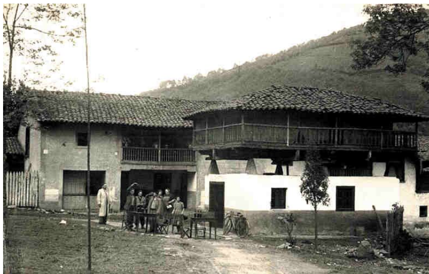
2.- Casa natal de Severino, en Riaño, a mediados del siglo XX. Delante de la misma se hallaba la panera, elevada en una típica estructura de hórreo para preservar los productos de la humedad y, bajo ella, el chigre, característica tienda asturiana donde se vendía y consumía sidra u otras bebidas. (Fotografía cedida por Alberto Rodríguez-Felgueroso)
