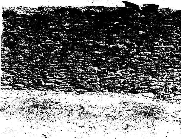
Fig. 6 Paredón del convento de agustinos: restos existentes.
